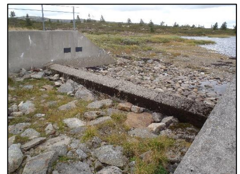
Bilde 40: Betongterskelen øverst i fiskerenna forbi dammen på Goppollvatnet. Det er laget et skår for vanngjennomstrømning på venstre side av terskelen.
