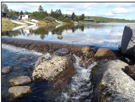
Bilde 42: Betongterskelen øverst i fiskerenna.
