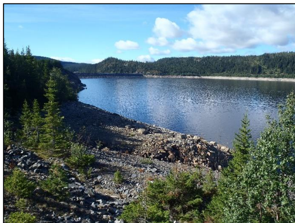
Bilde 27: Dokkfløymagasinet med Dokkfløydammen i bakgrunnen.
