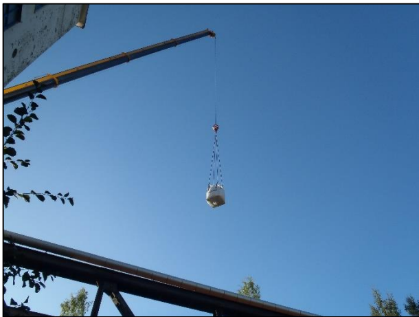
Bilde 72: Grus i storekk løftes ut over Hunnselva.
