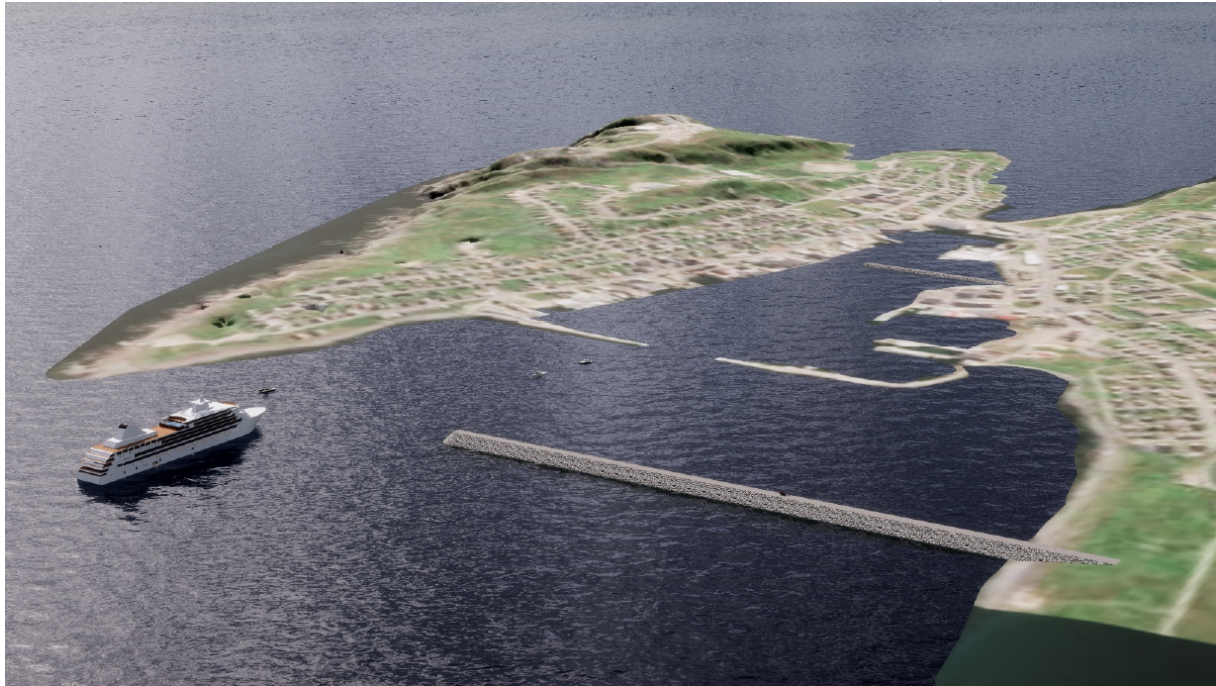
Figur 2: Modell av planlagt molo etter ferdigstillelse (Noconsult, 2024).
