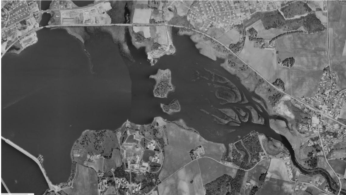
Figur 9 Flyfoto Svartelvdelta og «hovedbassenget» fra 1968 - før E6 ble anlagt over Kråkholmene. Utklipp av flyfoto Geodata AS - Kartverket, geovekst og kommuner.
