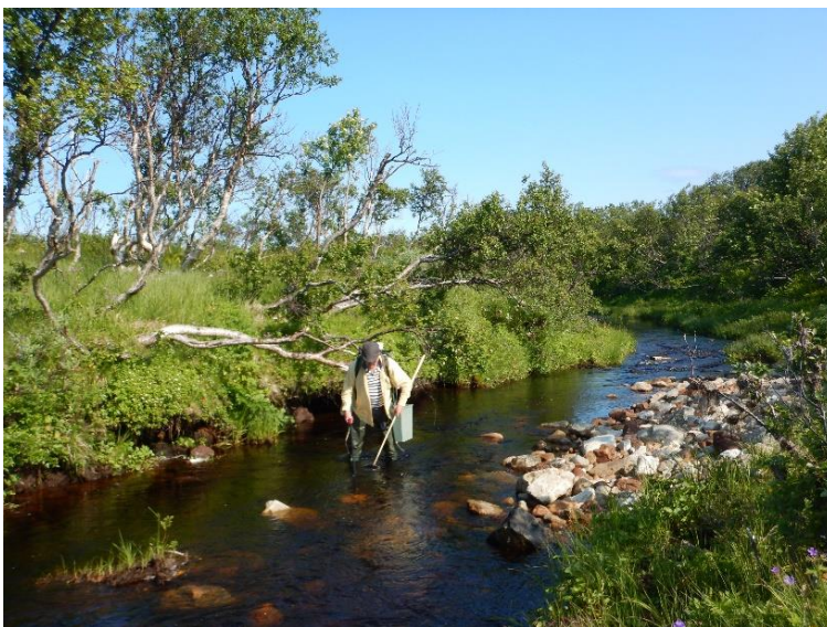
Nedenfor kulvert med utrast vei
