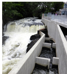
Vi hjelper fisken forbi vandringshindre ved å bygge fiskepassasjer.
