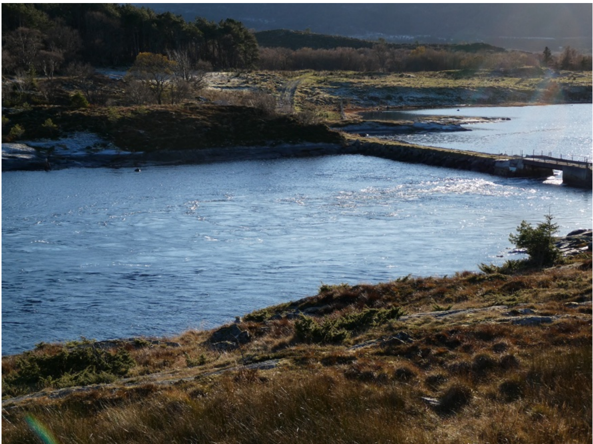
Figur 17. Den indre landbruksvegen og brua sett litt på avstand. Den kraftige strømmen som oppstår ved brua under overgang mellom flo og fjære dokumenterer effekten av brua på vannutskiftningen. Foto: Arnstein Gjeldnes
