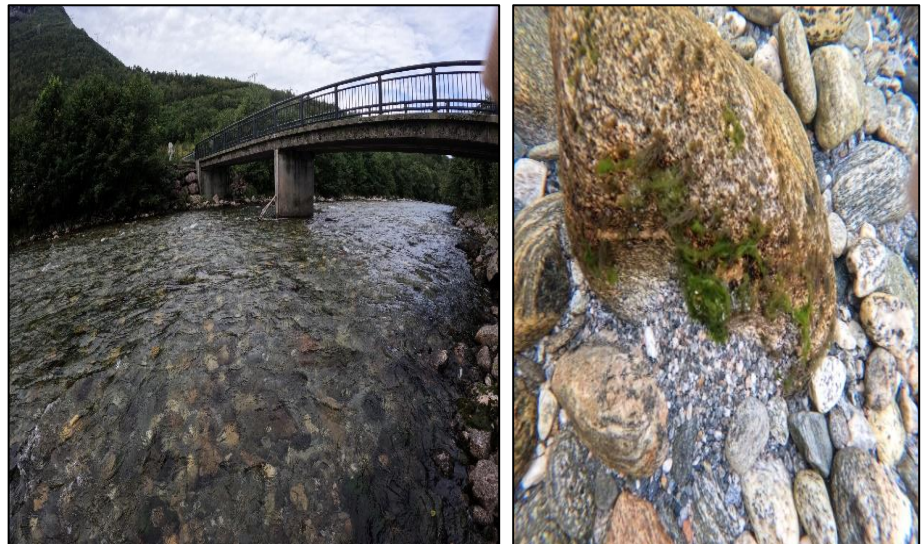
Figur 48 Situasjonfoto frå stasjon US3
