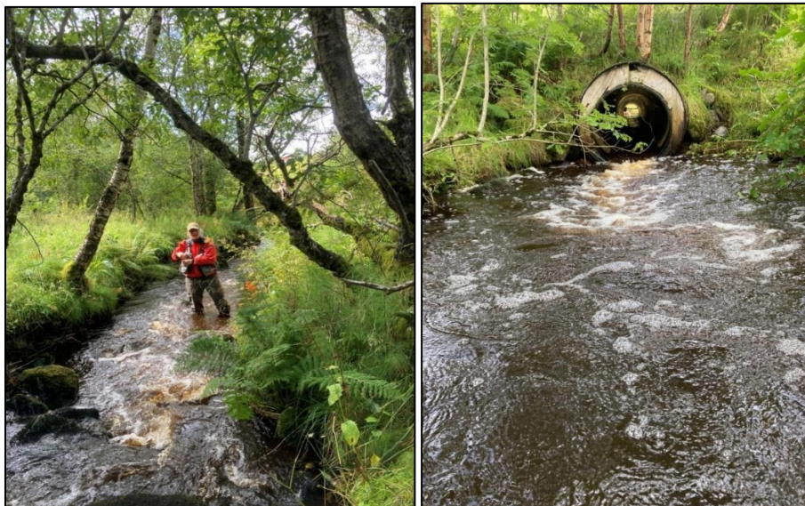
Figur 33 Nerbøvågen bekkefelt, t.v. stasjon NE1 nedstrøms, t.h. oppstrøms
