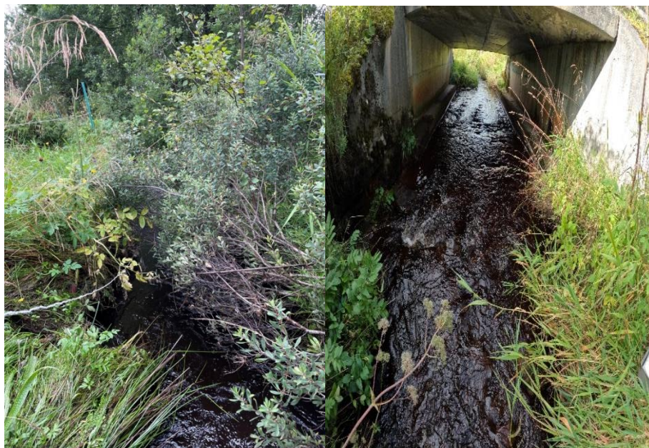
Figur 13 Bekken oppstrøms vegen renn gjennom eit myrområde
