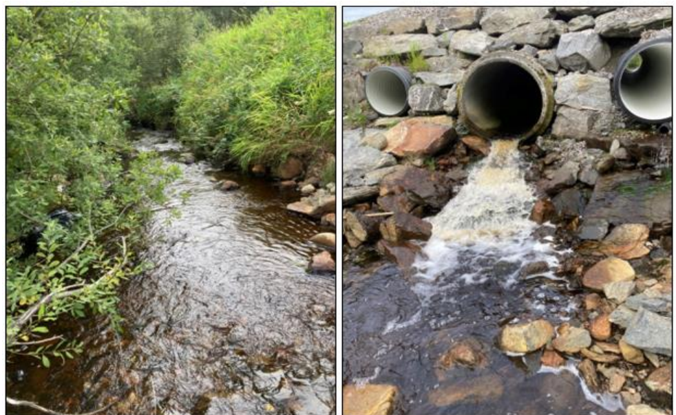
Figur 35 Stasjon TO3 Sett nedstrøms (t.v) frå vandringshinder (t.h.).
