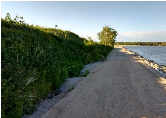
Bilde. Skjermvoll ved massegjenvinningsanlegget, juni 2020.
