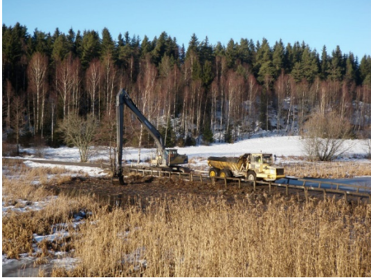
Illustrasjonsbilde. Oppgraving i Gjølsjøen naturreservat med gravemaskin med lang rekkevidde.
