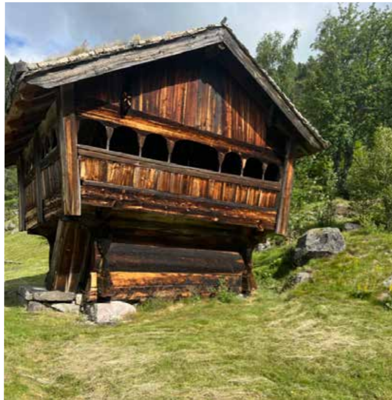
Loftet på Rygnestad er kjent for det kraftige dimensjonane i tømmeret som er brukt. Foto: RB
