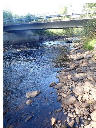
Figur 63: Oversiktsbilde ved stasjon 6.
