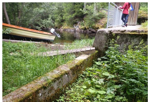
Figur 69: Velmundsdammen med bilde fra flompassasjen forbi dammen.
