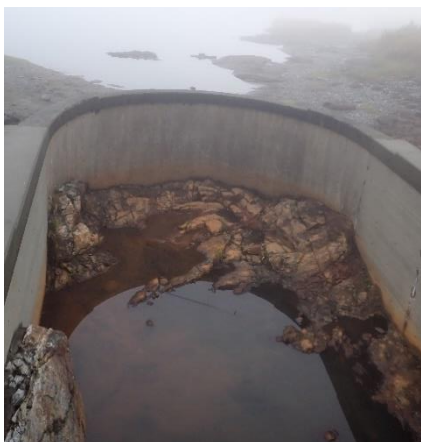
Figur 75: Dammen på utløpet av Raudsjøen.
