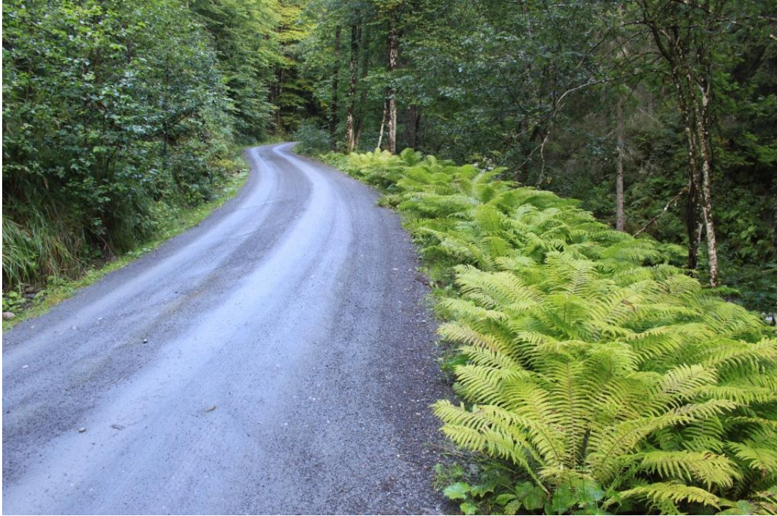
Figur 23. Skogsbilvegen i Svenådalen naturreservat 11.6.2012. Bildet viser kurvatur, enkle grøfter og vegstandard. Foto: Geir Høitomt
