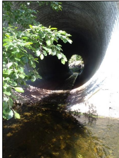
Hekshuselva- kulvert stasjon 2
