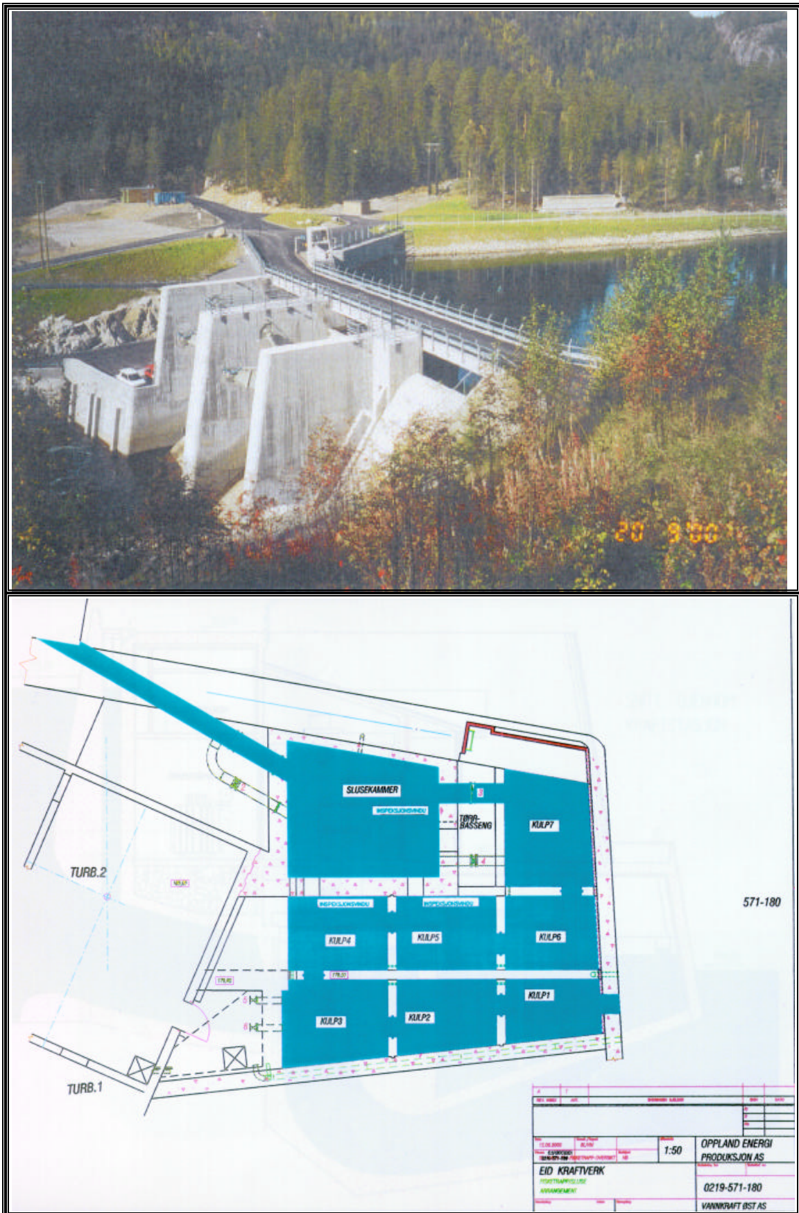
Bilde 20 Kraftverksdammen ved Eid (foto hentet fra Vannkraft Øst rapport)(øverst). Tverrsnitt av fisketrappa sett ovenfra (nederst).
