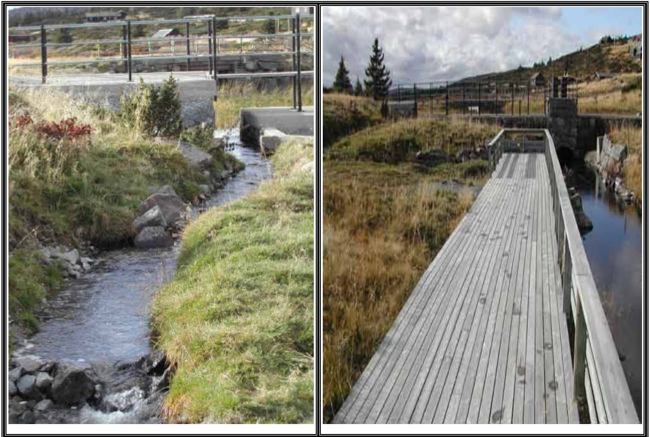
Bilde 10 Inntaket til fiskerenna på utløpet av Reinsvatnet (venstre). Fiskerenna på utløpet av Reinsvatnet. Fiskerenna ligger oppe i venstre kant (høyre).
