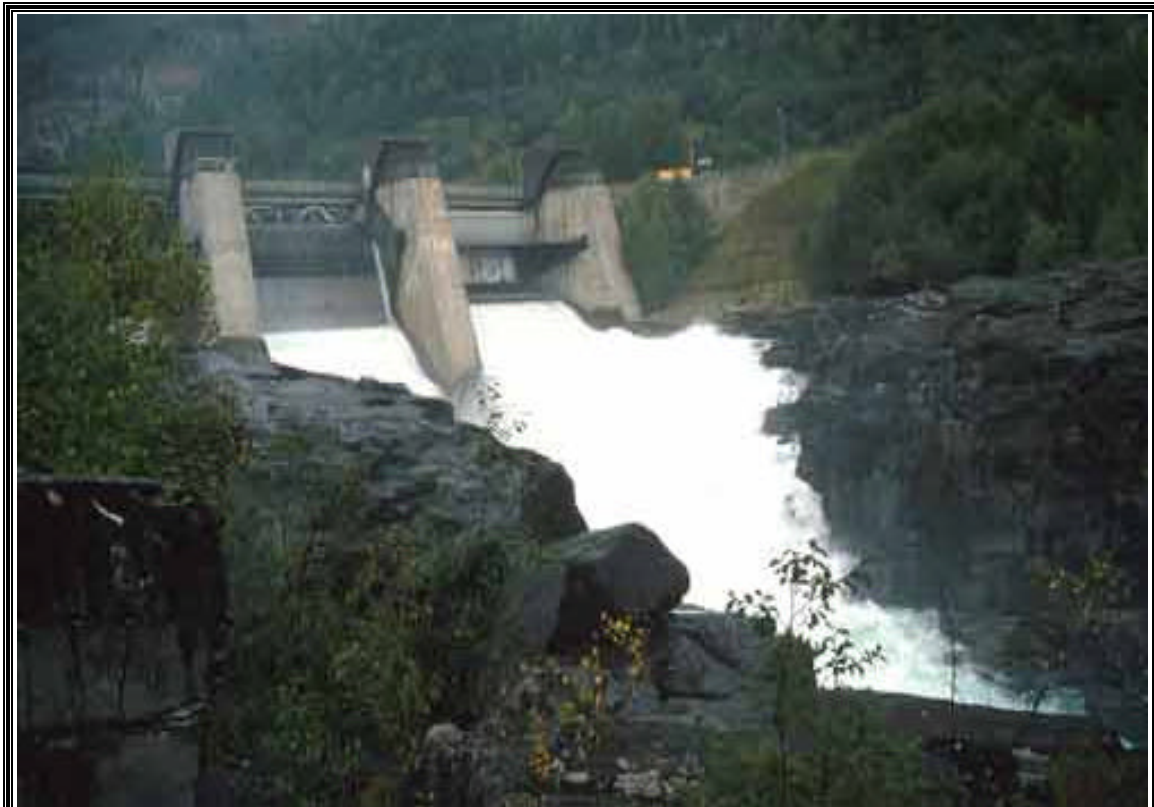
Bilde 12 Harpefosdammen med vannslipp gjennom flomlukene (øverst). Samløpet mellom Lågen og kraftverkstunnelen ved Grøntuvholet (nederst).
