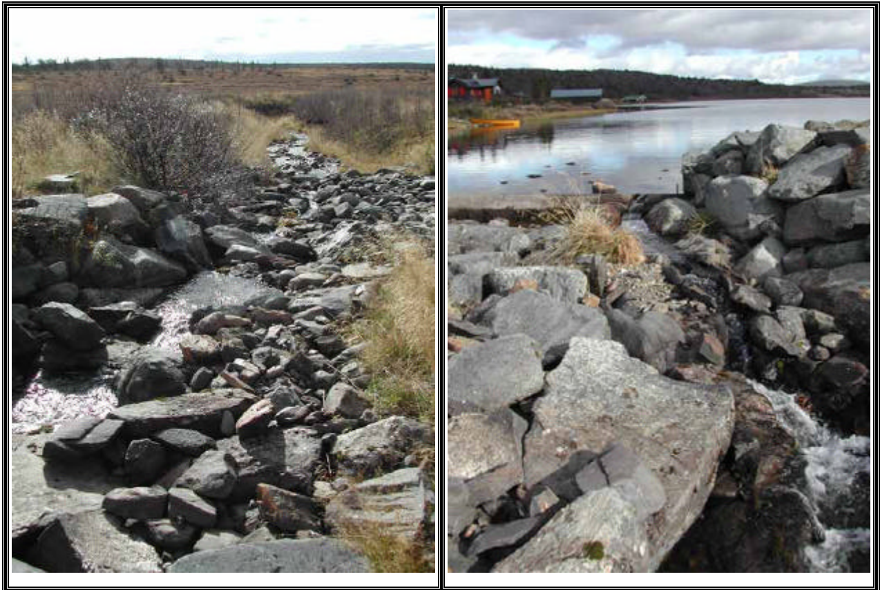
Bilde 5 Dammen på Djupen med tilførselsåpningen for vann til fiskerenna (høyre) og fiskerenna sett nedover (venstre)
