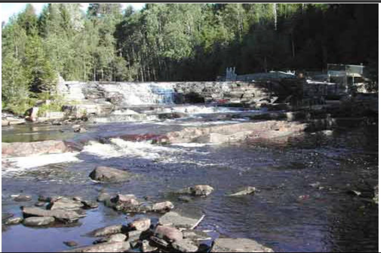
Bilde 18 Kraftverksdammen i Lomsdalselva med fisketrapp i høyre kant av bildet (øverst). Tegning av fisketrappa i Lomsdalselva (nederst).
