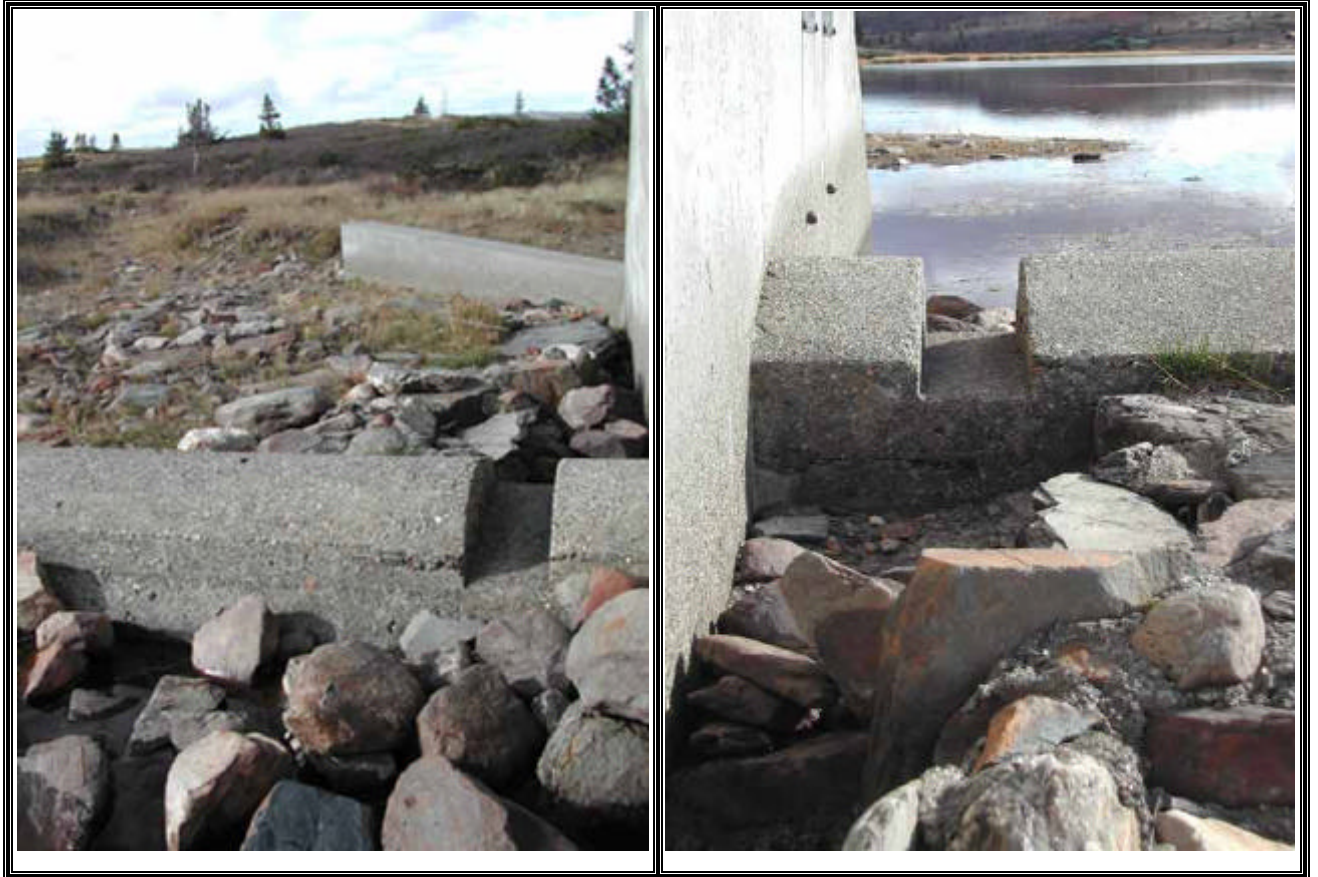
Bilde 4 Fiskerenna på utløpet av Goppollen sett nedover fra dammen (venstre) og av utløpsåpningen i dammen (høyre)
