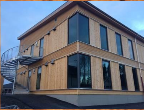
Hanstad skole, Elverum, moduler i massivtre. Ferdig til skolestart høsten 2017. Foto: Hans Erik Skari
