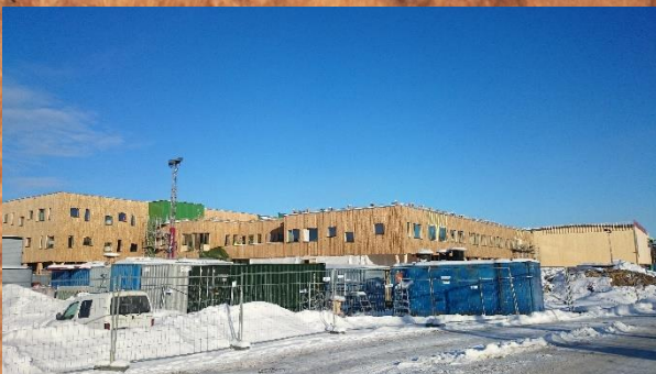
Kongsvinger ungdomsskole, bygd i massivtre. Foto: Tordar Sætheråsen
