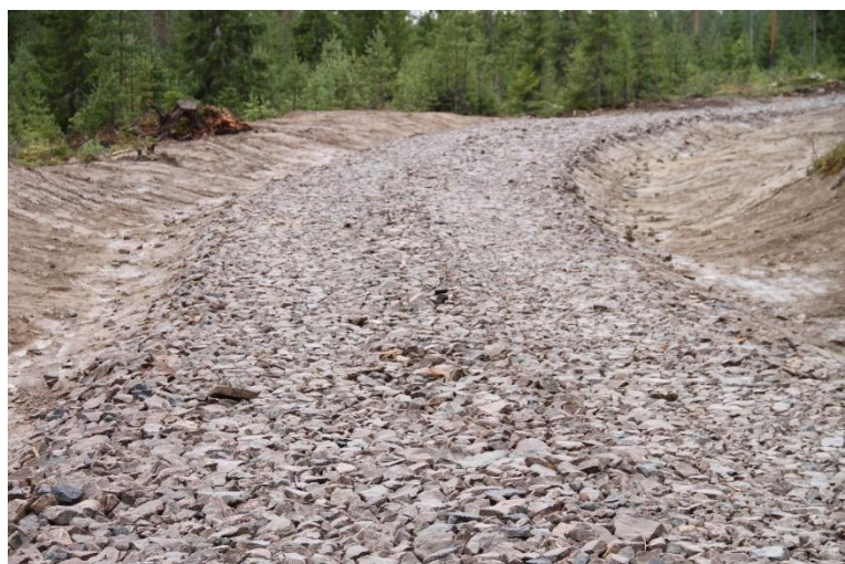
Samme vegen under oppbygging.
