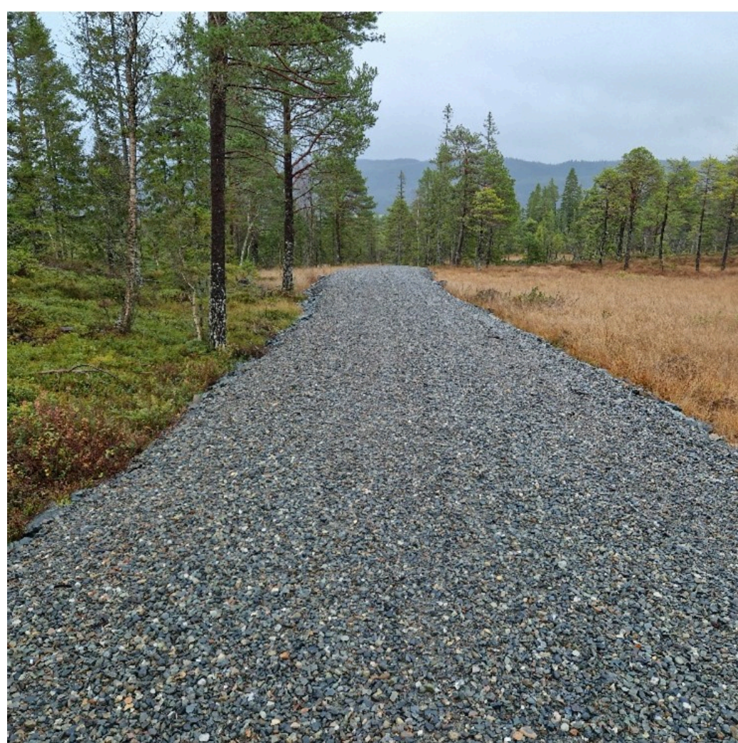
Bilde 4: Bygging av veg på duk og geonett gir en skånsom framføring av veg på myr uten gravetiltak, og holder myra intakt under veglegemet. Foto: Carl Olav Holen
