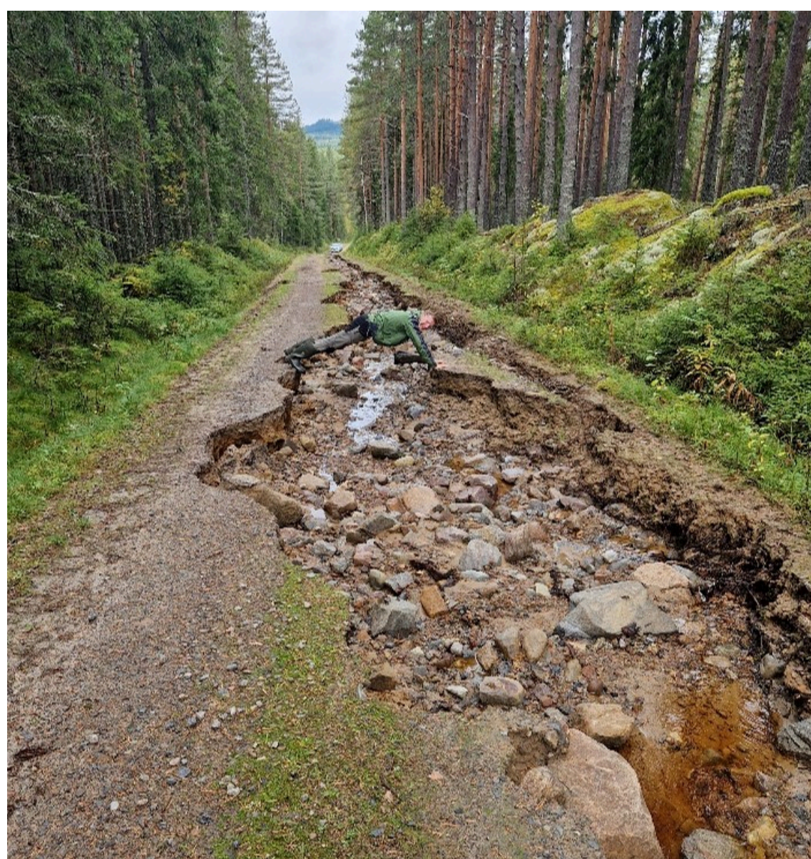
Bilde 10: Styrtregn har ført til store skader på mange skogsbilveier i 2024. Foto: Michael Anderson
