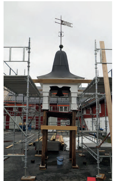
Restaurering av klokketårnet på Tommelstad, Hamar
