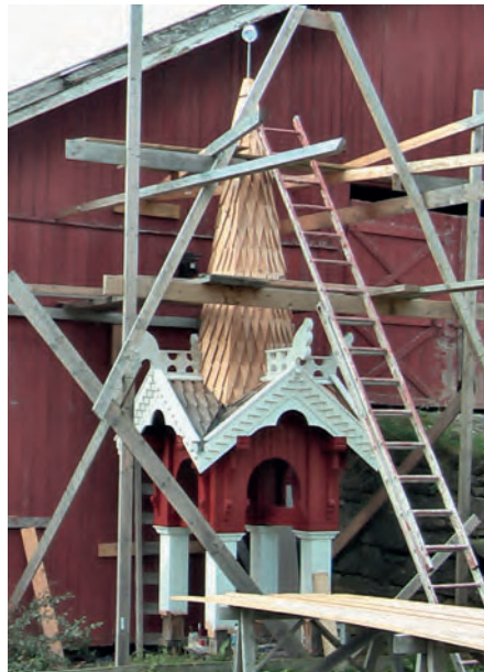
Restaurering av klokketårnet på Saug vestre, Ringsaker
