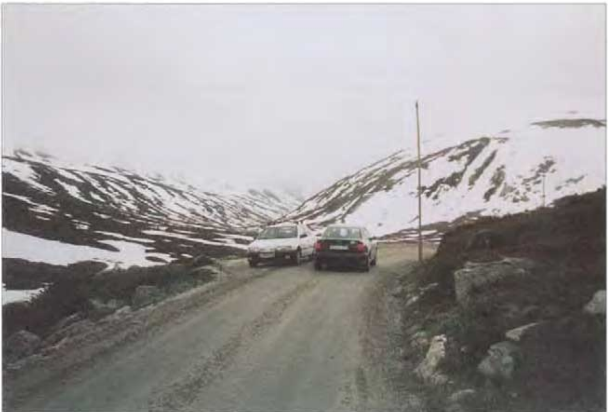
RV 258, gamle Strynefjellsvegen, blir rusta opp til turistveg. Viktige reinstrekk kryssar denne. (Foto: Ola Betten)
