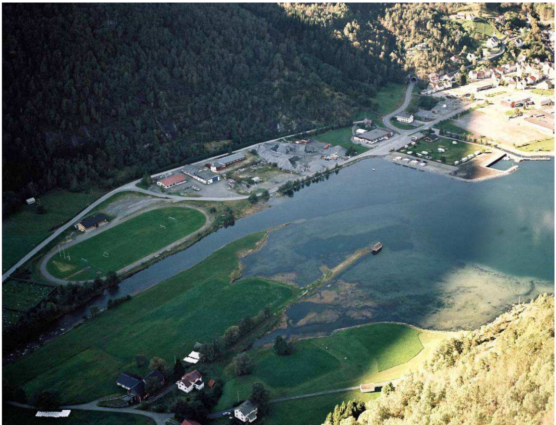
Bildet viser deltaområdet ved utløpet til Korsbrekkeelva. Den planlagte kaia vil ligge ute til høgre for bildekanten. Deltaet er som ein ser av bildet langgrunn, og har ei stor flate med nivå omtrent på kote 0. Foto: Naturbase.
