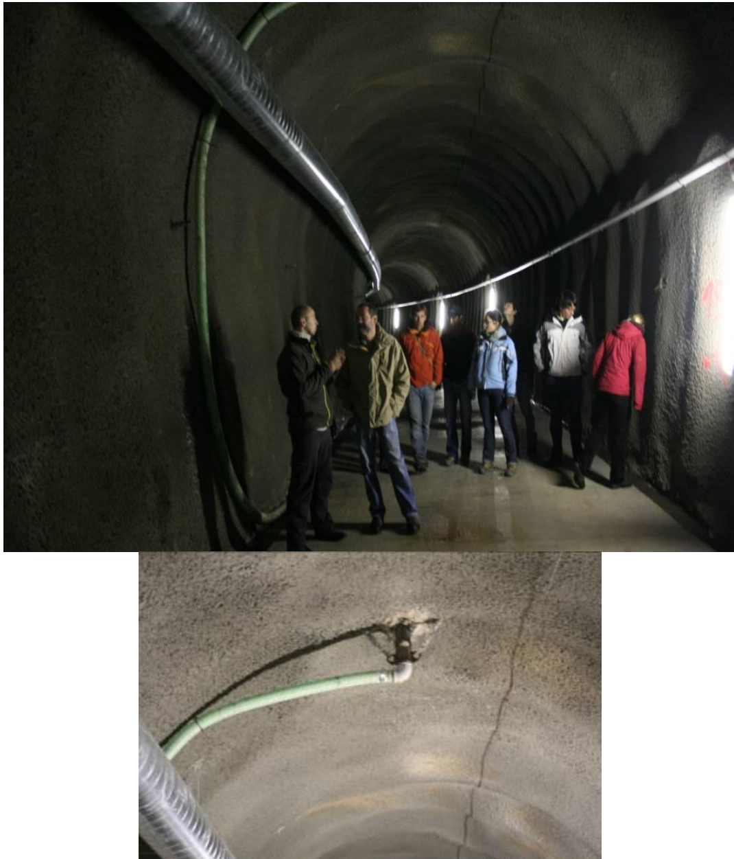
Figur 11. Fra den 0,7 km lange tunellen ved La Frasse i Sveits. Under sees et av de 50 vertikale borehullene i tilknytning til tunellen.
