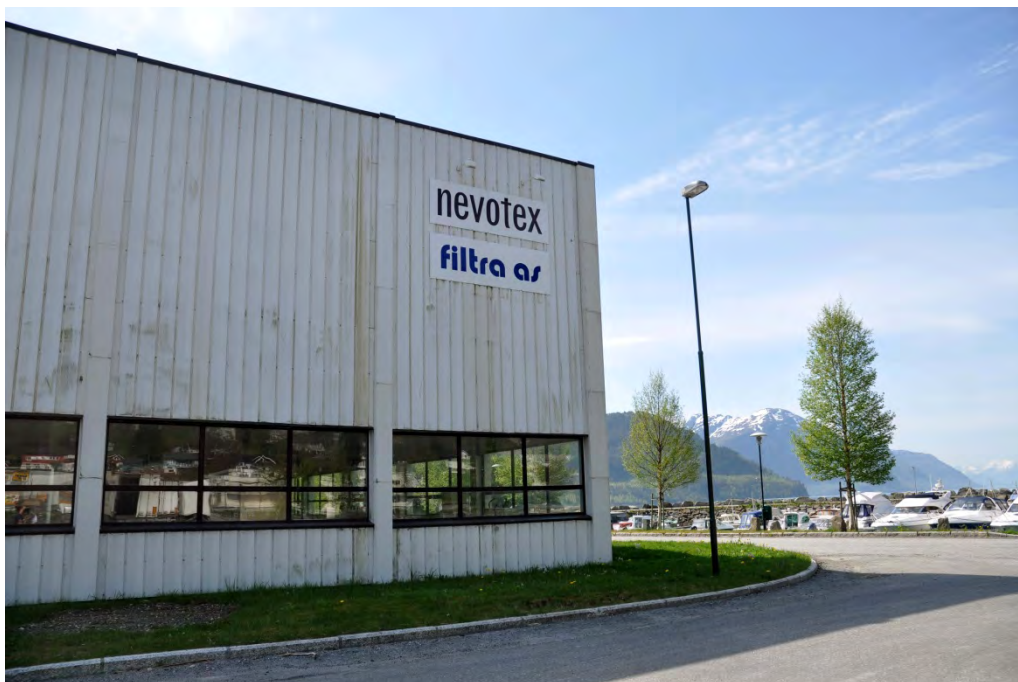
Figur 18: Nordlige del av bygg nærmest smørbåthavna (bygg også vist i Figur 12).
