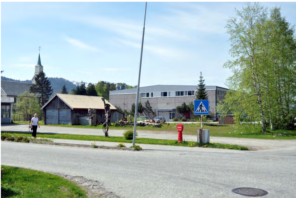
Figur 36: Område øst for T.K. MEK sett mot vest. Sjøholt kirke sees i bakgrunn.
