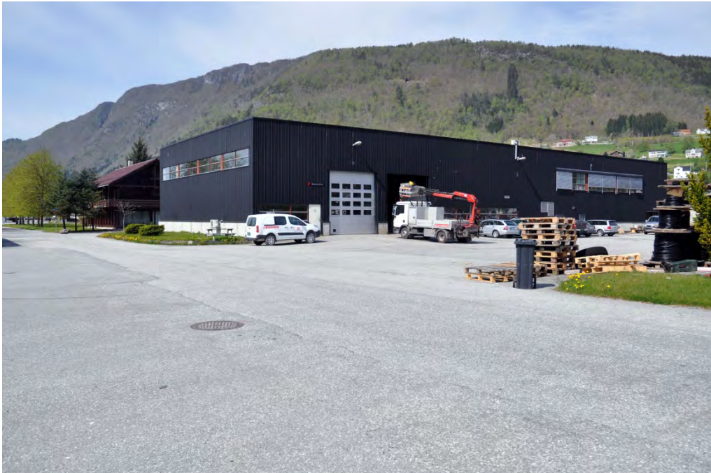
Figur 34: Ørskog Energi, bygget sett mot nordvest.
