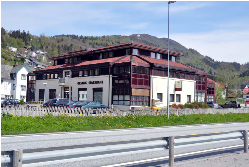
Figur 27: Bankbygg, sørøst for Rådhuset, mot nordøst.
