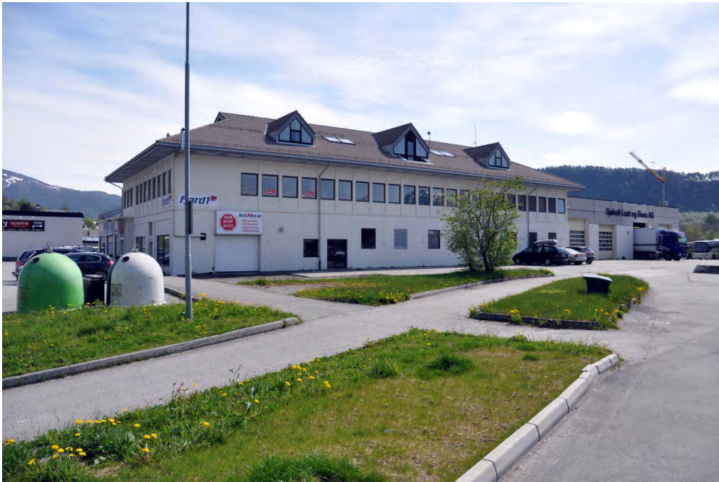
Figur 23: Stort bygg øst for bensinstasjonen. Bygget inneholder kontorer, butikk og verksted/garasjer.
