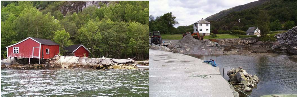
Figur 2.9: Eksempel på ødelagt naust ved Leirpoll (til venstre, oppskyllingshøyde 3 m) og ødelagt molo/havnebasseng ved Indre Hatlem (til høyre, oppskyllingshøyde 4 m) etter fjellskredet fra Katlenova ned i Sjørefjorden i Hyllestad i 1998.
