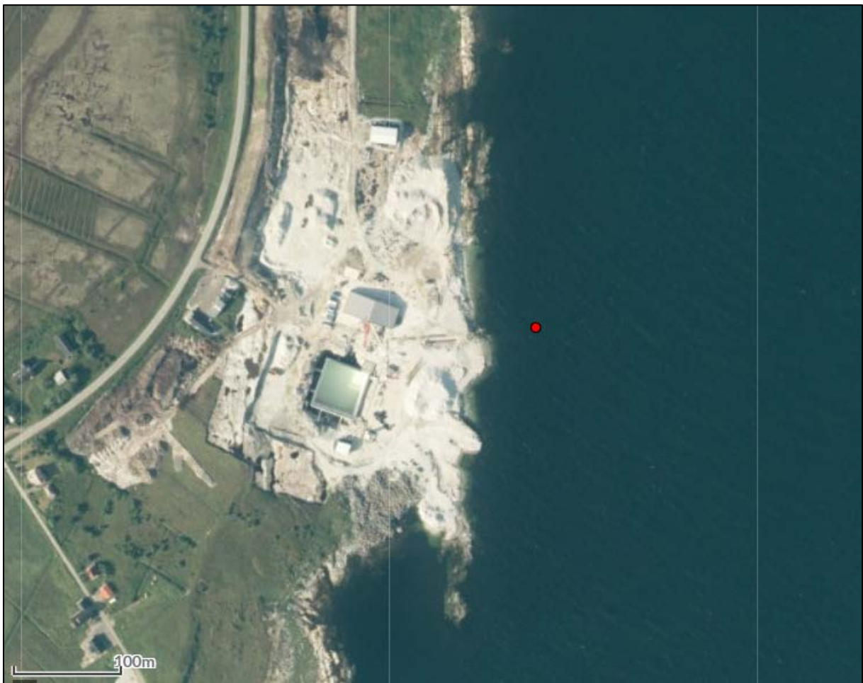
Figur 1. Foto av anleggsområdet ved utbygging i 2021. Plassering av midlertidig utslippspunkt er markert med rød sirkel.
