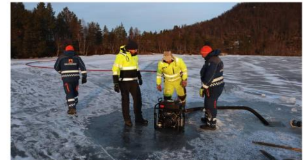
Hamarøy kommune sliter med vannforsyningen. Her pumpes det vann fra Jensvannet over i tanker som fraktes til drukkervannskilden i Ulvsvåg. FOTO: LARS BJØRN MARTINSEN / NRK
