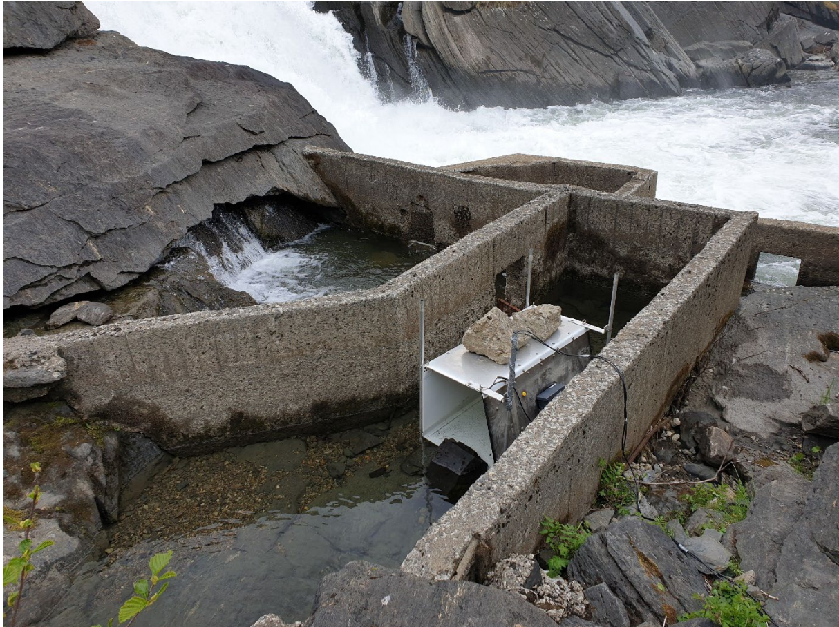
Bilde: Plassering av videotunellen i fisketrappa i Drevja. I forkant av videotunellen er det montert et ledegerje slik at fisken ikke kan passere utenom. Fotograf: Aslak Darre Sjørusen
