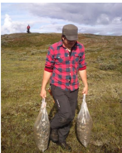
Utlegging av gytegrus. Grusen fraktes ut i sekker, og legges ut i bekkene på områder der både vannhastighet og vanddyb blir vurdert som gunstig.
