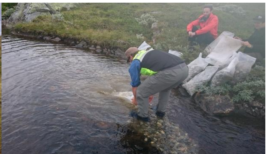
Utlegging av gytegrus. Grusen fraktes ut i sekker, og legges ut i bekkene på områder der både vannhastighet og vanddyb blir vurdert som gunstig.
