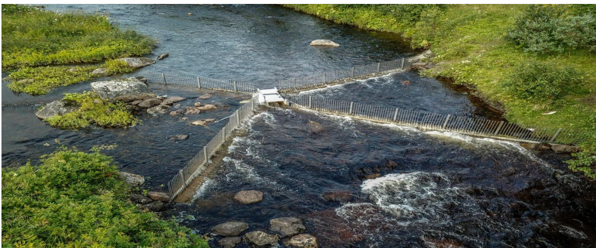
Bilde 2 Vaki installasjonen med ledegjerder i Åelva
