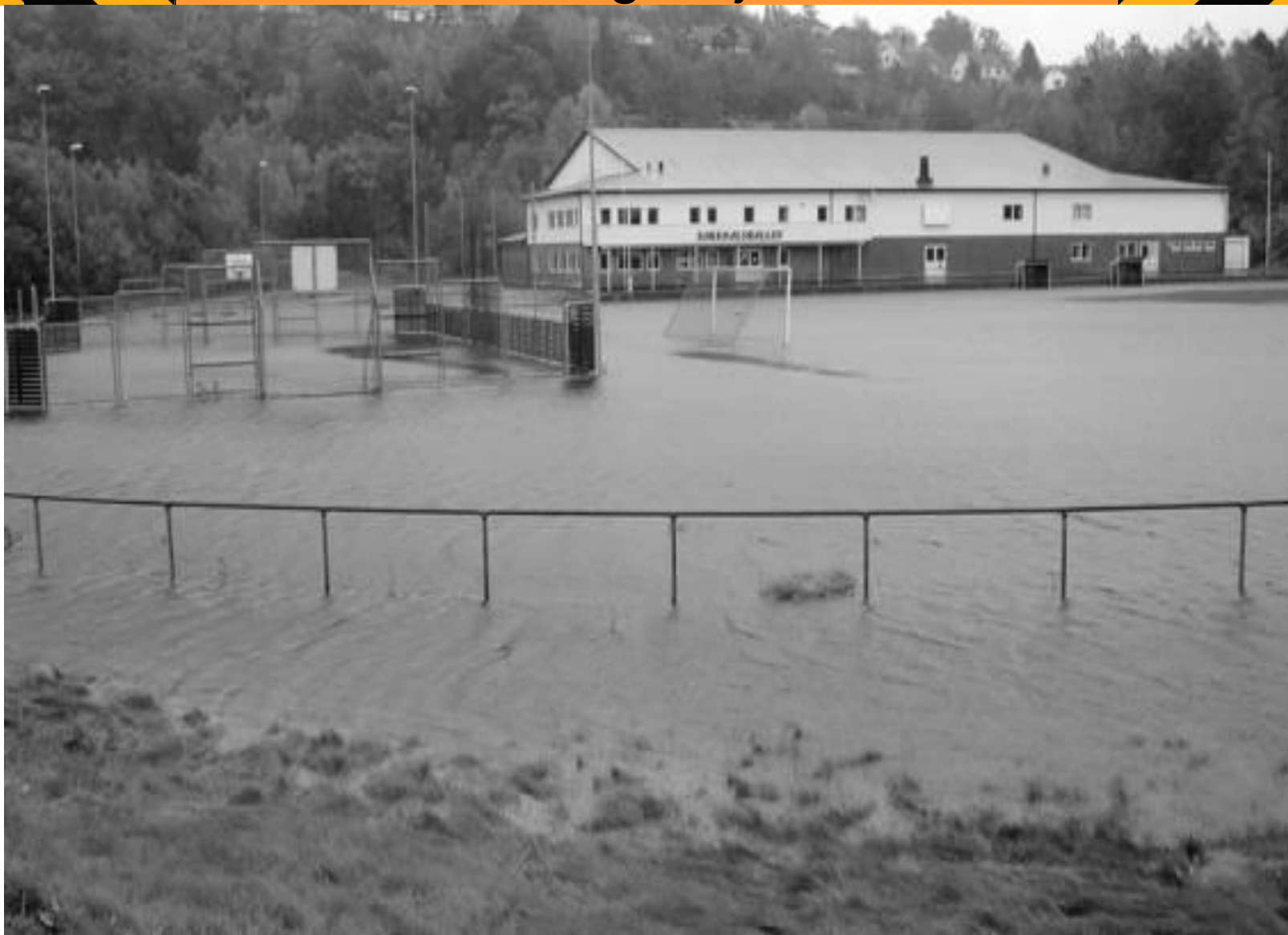
Sokndalshallen - idrettshall med fotballbane oversvømmet
