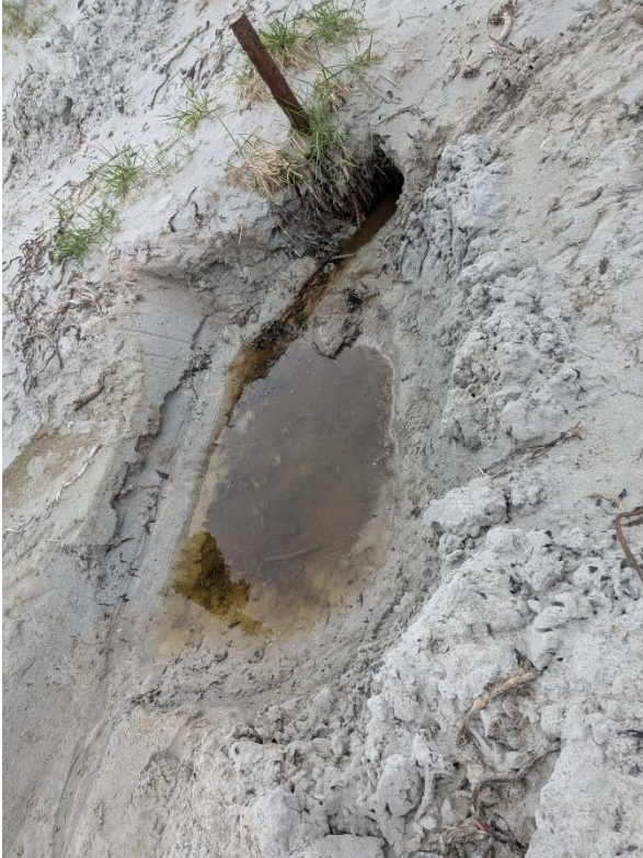
Figur 2: Ferdig vedlikeholdt dreneringsrør - og grøft. Foto: Statsforvalteren i Rogaland, 22.mai 2026
