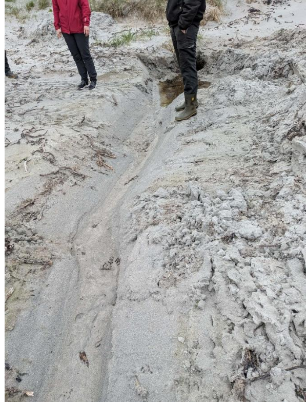
Figur 2: Ferdig vedlikeholdt dreneringsrør - og grøft. Foto: Statsforvalteren i Rogaland, 22.mai 2026
