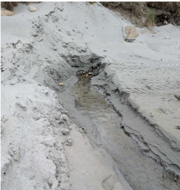
Figur 4: Ferdig vedlikeholdt dreneringsrør - og grøft. Foto: Statsforvalteren i Rogaland, 22.mai 2026
