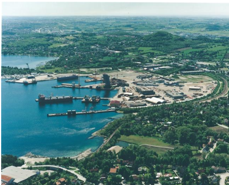
Fig. 46: Luftfoto av tidligere anleggsområde i Jåttåvågen med utfylte strandområder, pirer og mellomliggende sørdokk og norddokk.
