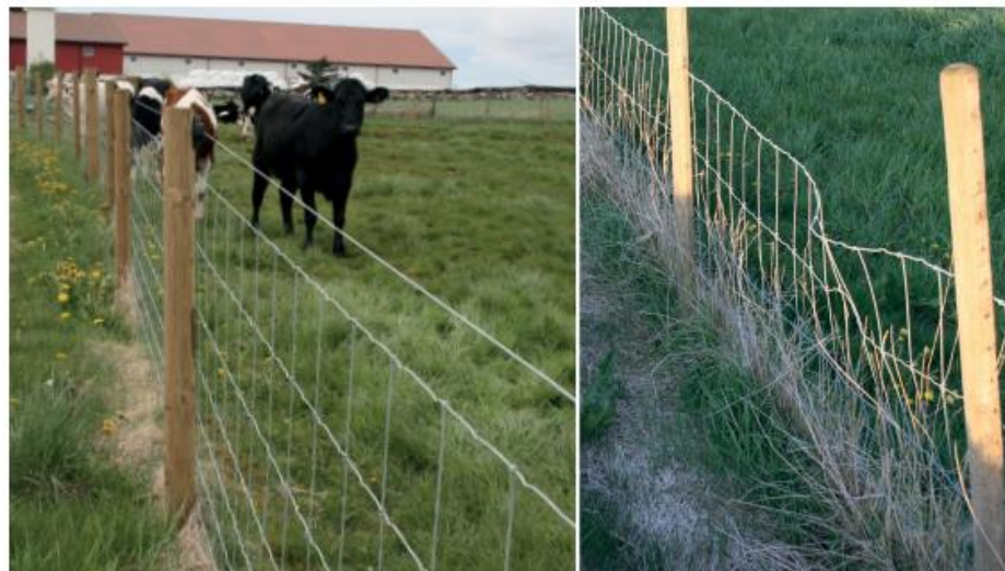
Et ht-gjerde (t.v) er svært strekkfast og tåler stor belastning uten at gjerdet endrer karakter. Et mild steel-gjerde (t.h) strekker seg ved belastning, og blir buktete og løst.
