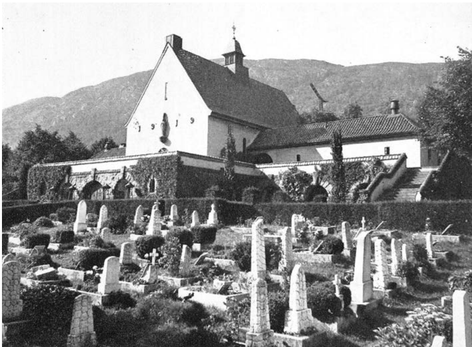
Solheim kapell sett fra utsiden. Kolumbarium verdig lokalisert under terrassen med direkte adgang fra kirkegården. (Foto: Norsk kremasjonsforening, 75 år, s. 10, fotograf ukjent, u.å.)
