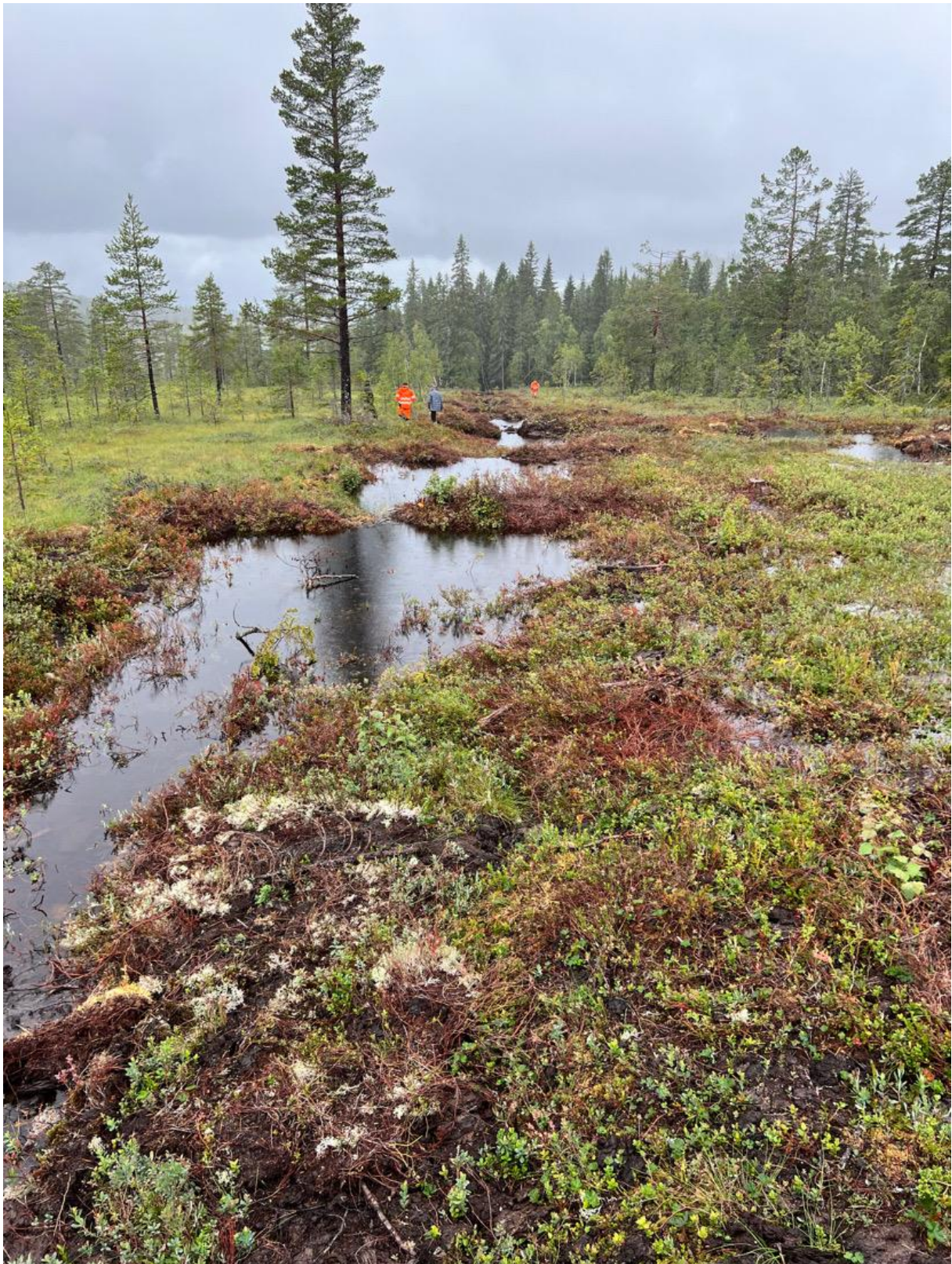
Figur 22: Flere demninger med brudd grunnet bruk av stein i demningen. Hemberget naturreservat 2023. Foto: Suzanne Wien
