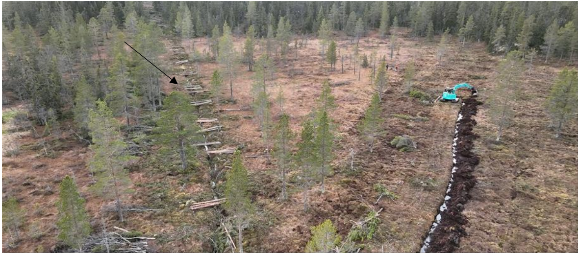
Figur 25: Tømmerstokker som er lagt klare der det seinere skal bygges forsterkede demninger, Vollmyra i Rendalen kommune. Foto: Kjølsv. Falklev
