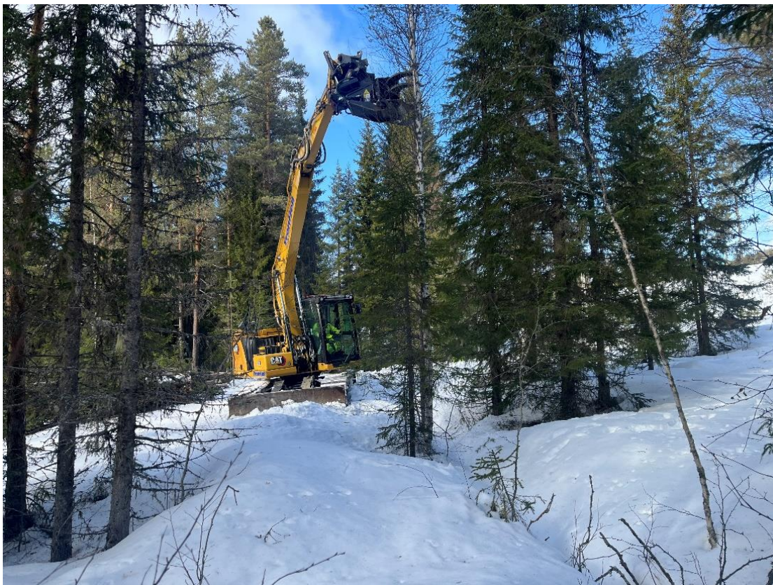
Figur 4: Vinterhogst med klippaggregat på gravemaskin. Kun store trær ble felt og lagt i hauger ved grøftene. Orreleikmyra, Trysil kommune 11. mars 2024. Foto: Kjølsv. Falklev.
