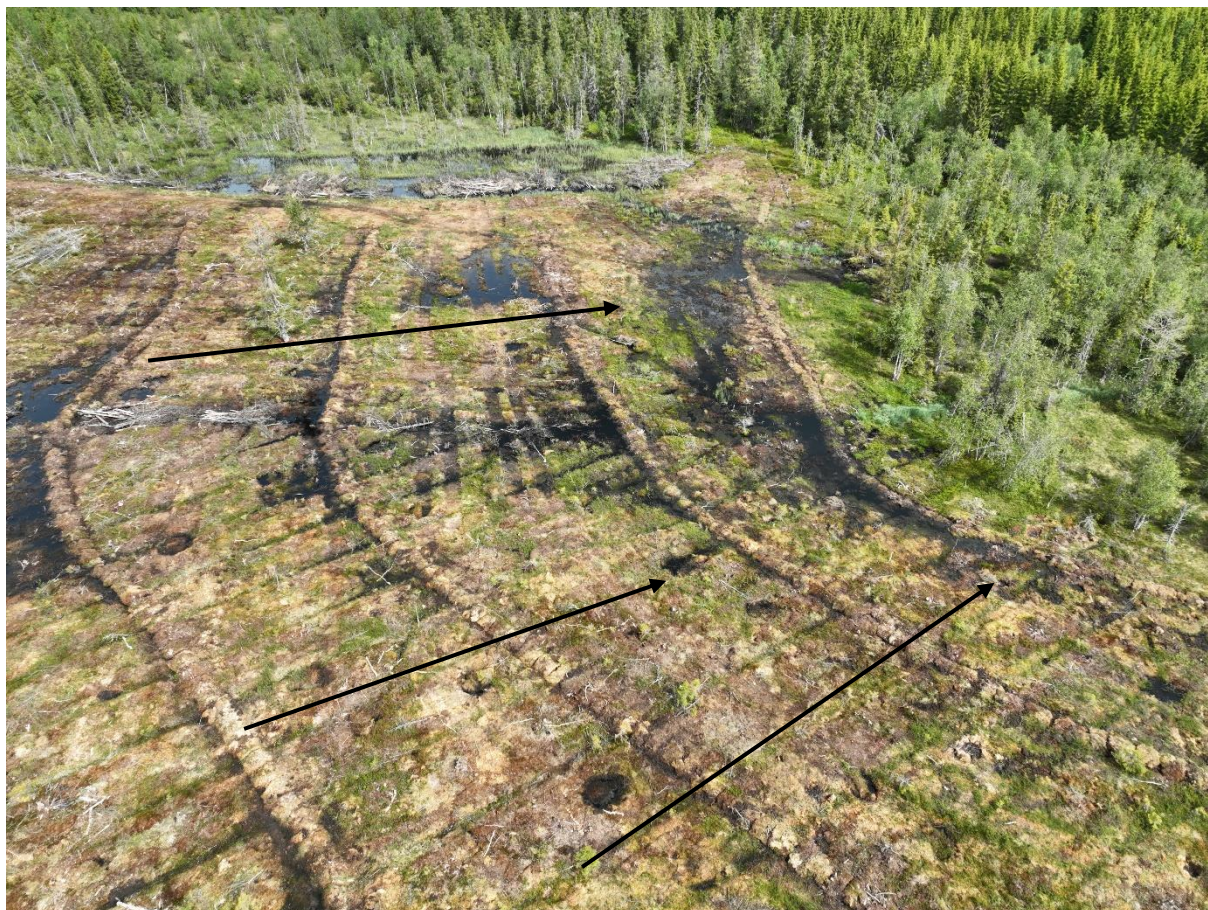
Figur 35: Torvmyra i Gjøvik kommune. Konturdemningene ligger på høydekanturene for hver 40 cm fall i terrenget. Svarte piler viser helningsretningen. Foto: Kjølsv. Falklev
