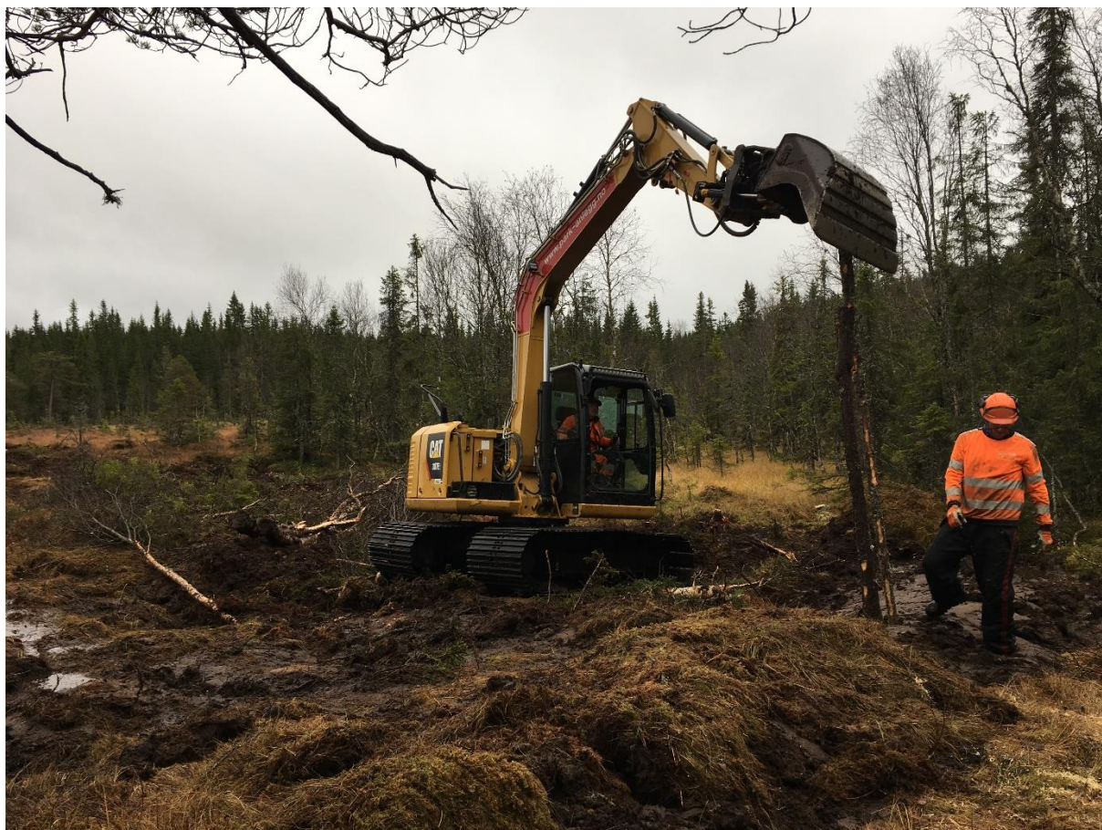
Figur 28: Forsterket demning med stående tømmerstokker. Vindflomyra 17. oktober 2017. Foto: Kjølsv. Falklev
