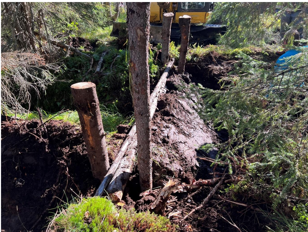
Figur 27: Tilnærmet fullført demning forsterket med tre. Foto: Kjølsv. Falklev.
