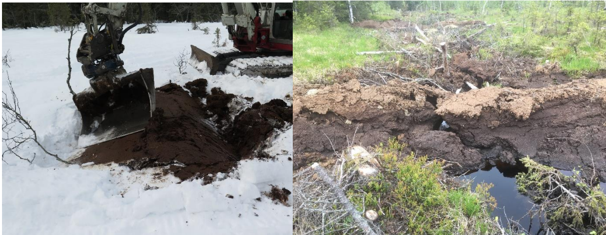
Figur 23: Bygging av demninger vinterstid er ikke å anbefale. Bygging til venstre og resultatet til høyre. Foto: Kjølvs Ø. Falklev
