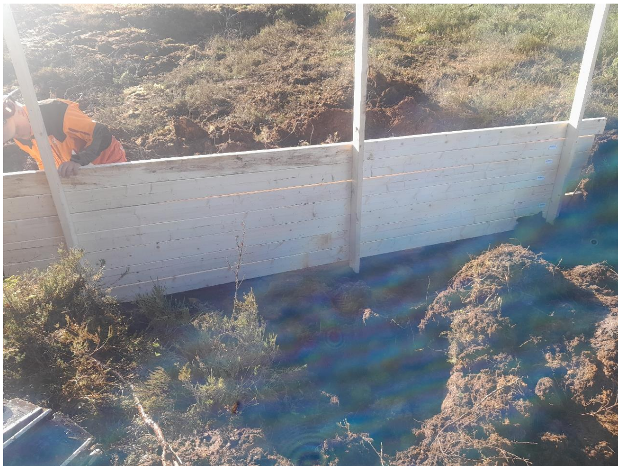
Figur 30: Plankedemning før den dekkes til med torv på begge sider av plankeveggen. Foto: Tommy Mellestuen
