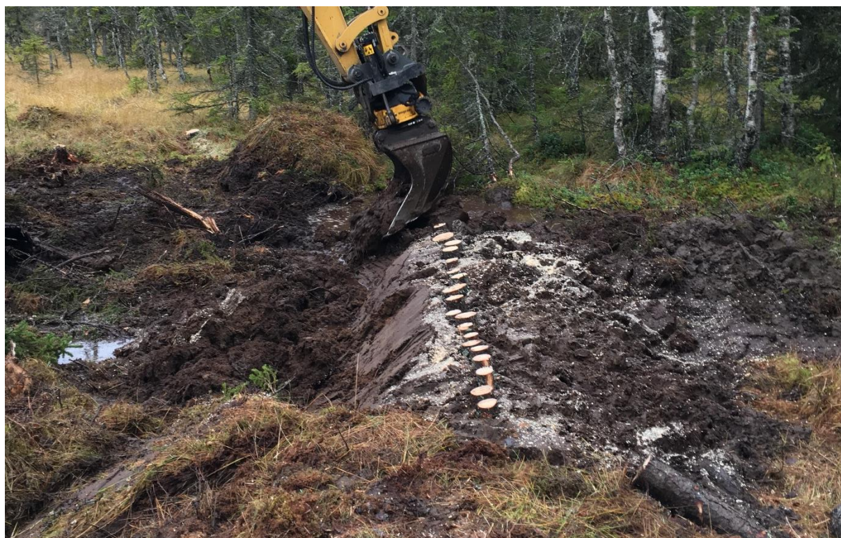
Figur 29: Forsterket demning med stående tømmerstokker. Vindflomyra 17. oktober 2017. Foto: Kjølsv. Falklev
