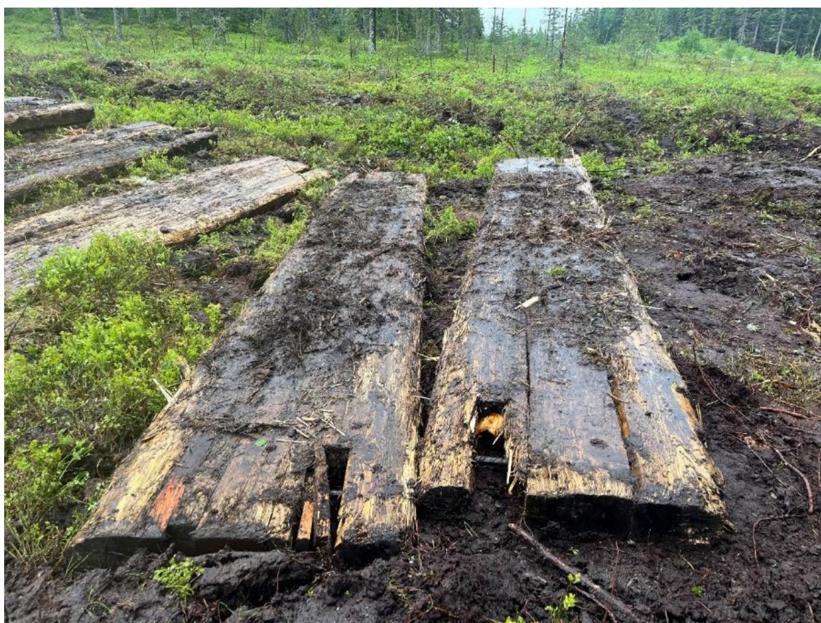
Figur 47: Eksempel på stokkmatter som gravemaskina kan stå på for å få bedre bæring. Foto: Kjølsv. Falklev
