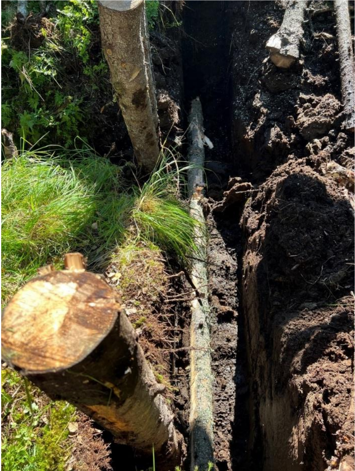
Figur 26: Begynnelsen på en demning forsterket med tre. Her er det også satt to støttestokker midt i grøfta. Grøfta går fra høyre til venstre i bildet. Foto: Kjølsv. Falklev
