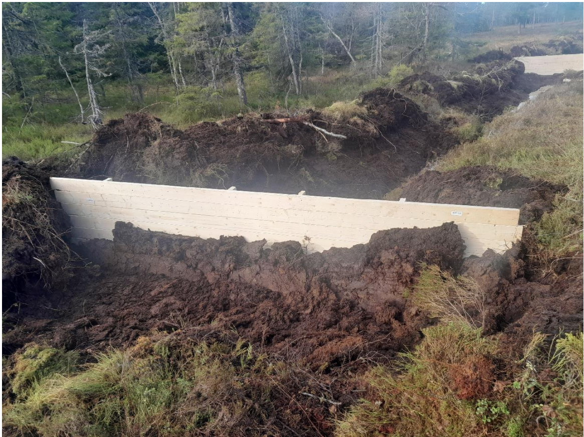
Figur 31: Plankedemning. Maskinfører har begynt å pakke den inn med torv: Foto: Tommy Mellemstuen
