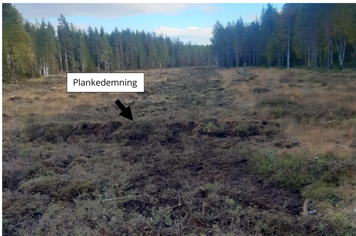
Figur 32: Plankedemning etter at den er ferdig bygd. Dekket med torv og vegetasjon på toppen. Foto: Tommy Mellemstuen.
