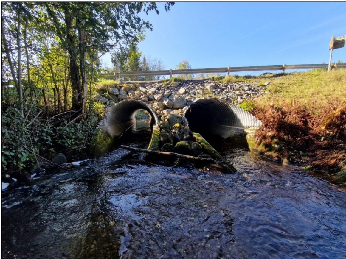
Figur 55: Bilde av Gullerudselva, oppstrøms for Røykenviklinna (Fylkesvei 34) bru, hvor to kulverter kan bli observert. Foto: Thomas Ustveit
